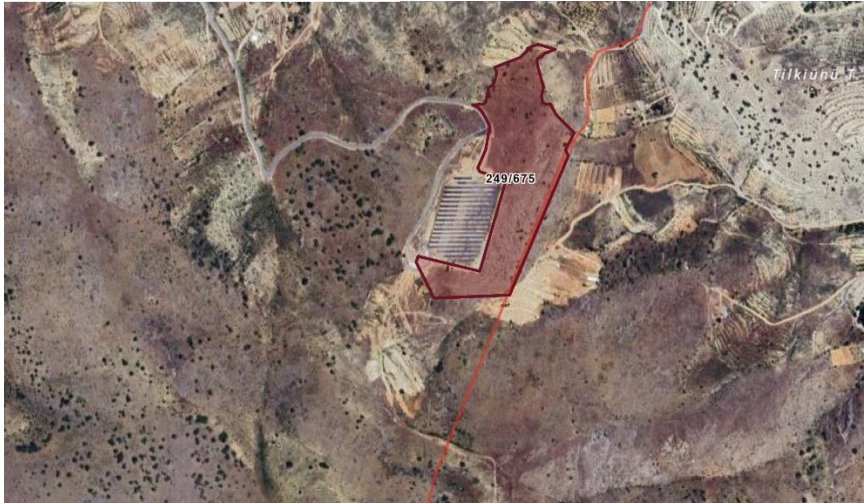
Resim 2. Yeşilyurt Belediyesi Güneş Enerji Santrali Proje Sahası
